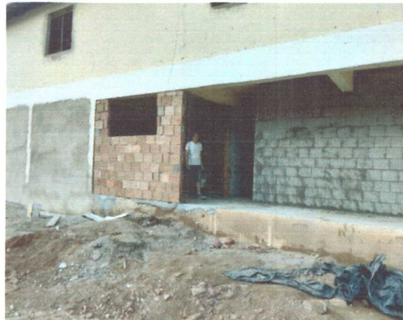
Início de alvenaria no primeiro pavimento do prédio da guarda
