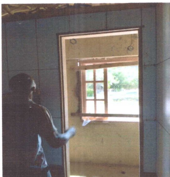
Cocação de conduíte e caixas de passagem no parque
