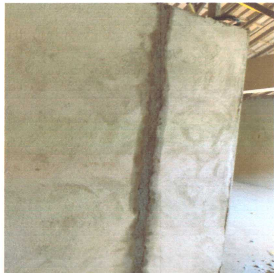
Aplicação de reboco e chapisco
