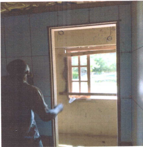
Colocação de revestimento no Banheiro
