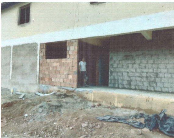
Aplicação de reboco e chapisco
